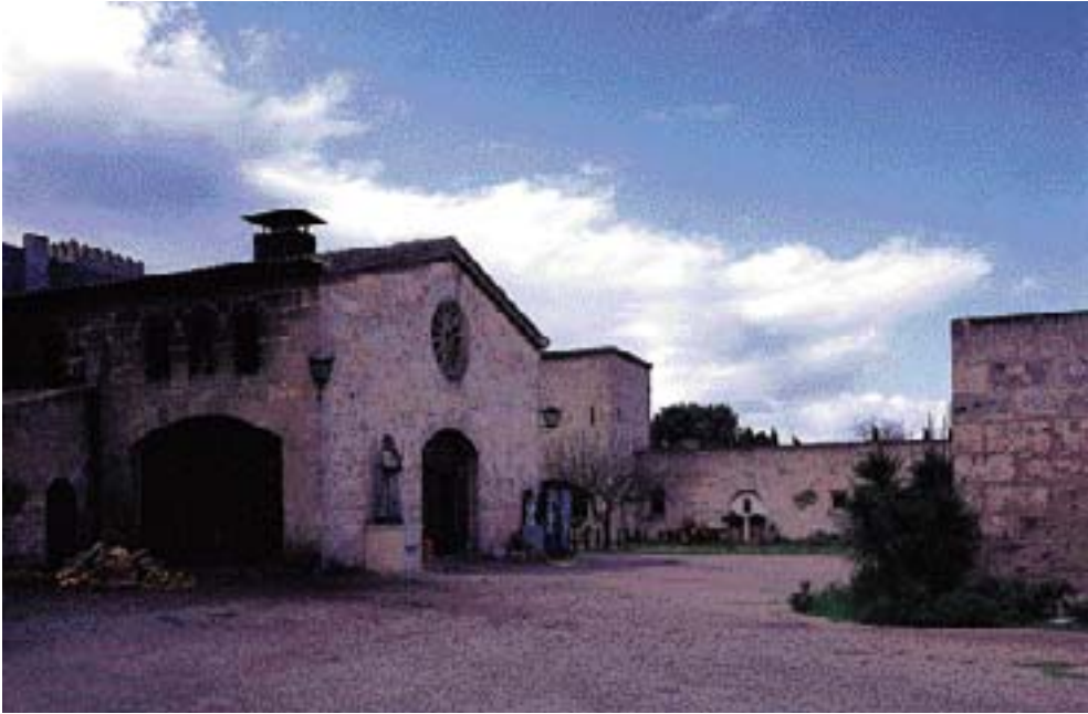
Patio interior, acceso a los hornos.
